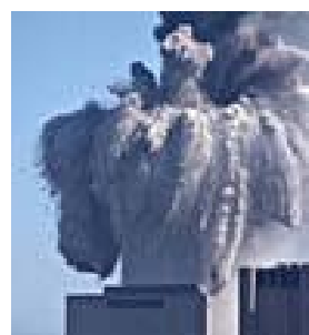
Fig.2 : Destruction de la Tour Nord – Vue latérale
