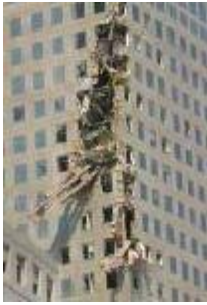
Fig.1 : Poutres d'acier empalées dans un immeuble
