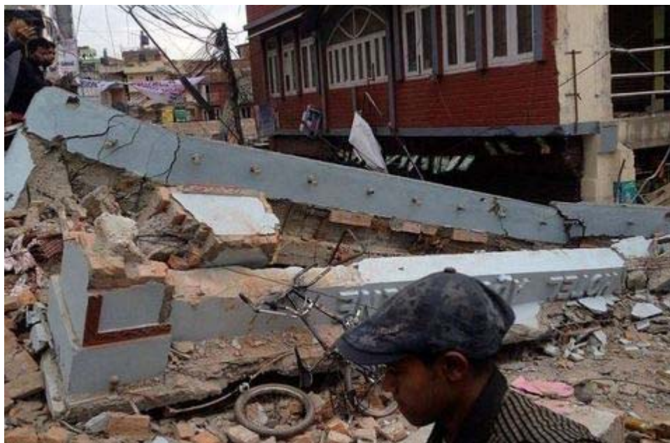
Dégâts produits par le séisme. Photo avec la permission de Krish Dulal
