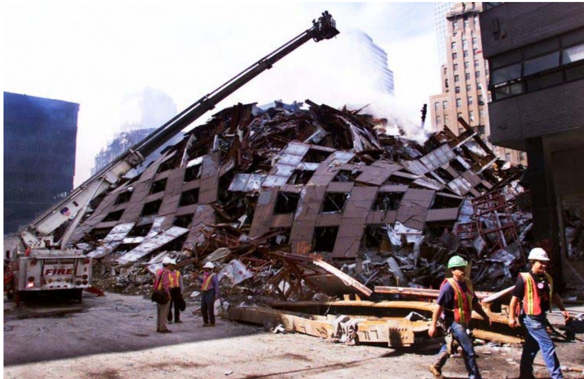
Des pompiers arrosent au jet les restes fumants du 7 World Trade Center Mardi 18 septembre 2001
