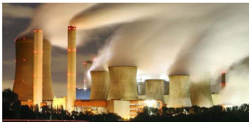
La centrale à charbon de Niederaussen en Allemagne. Le revers de la médaille.
