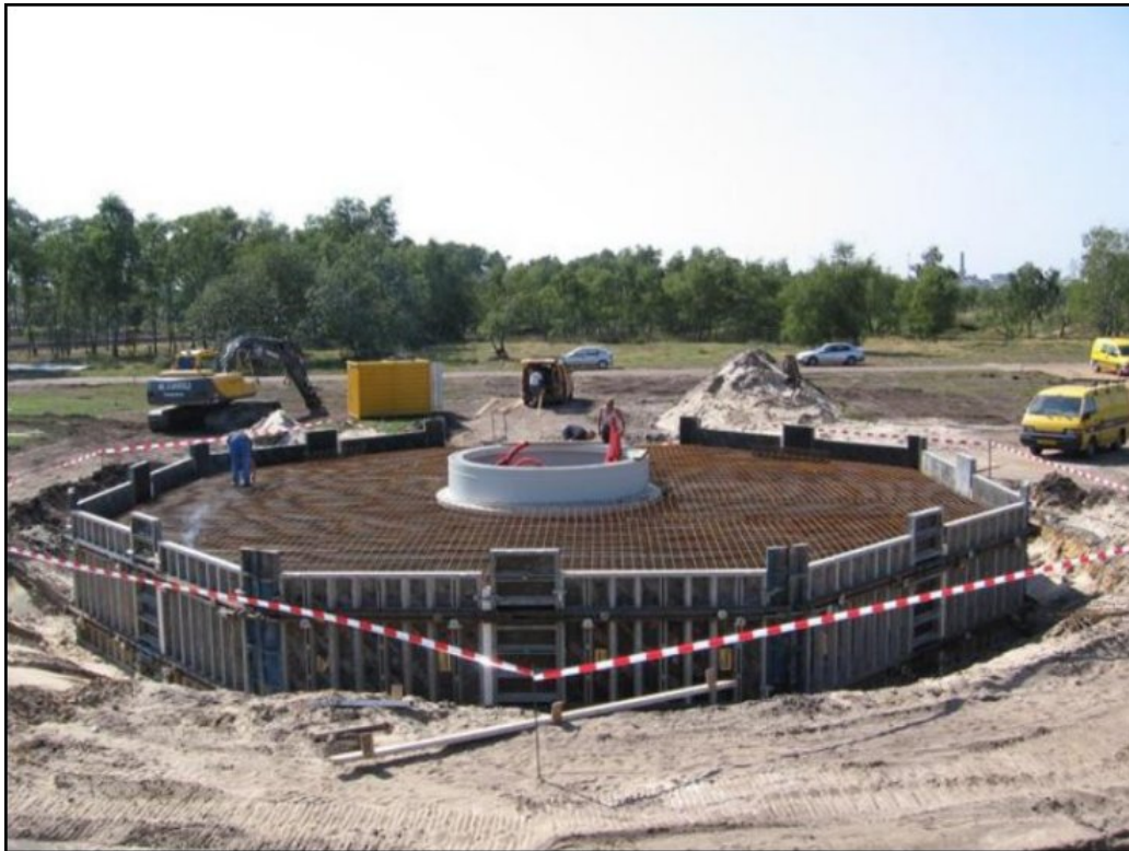
La fondation de 25 m. de diamètre et 3 m. de profondeur recevra 740 m 3 de béton soit 1700 tonnes.
