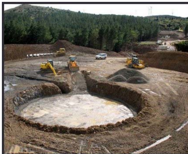
Un chantier qui va défigurer irrémédiablement le paysage. Une cicatrice qui ne se refermera jamais.
