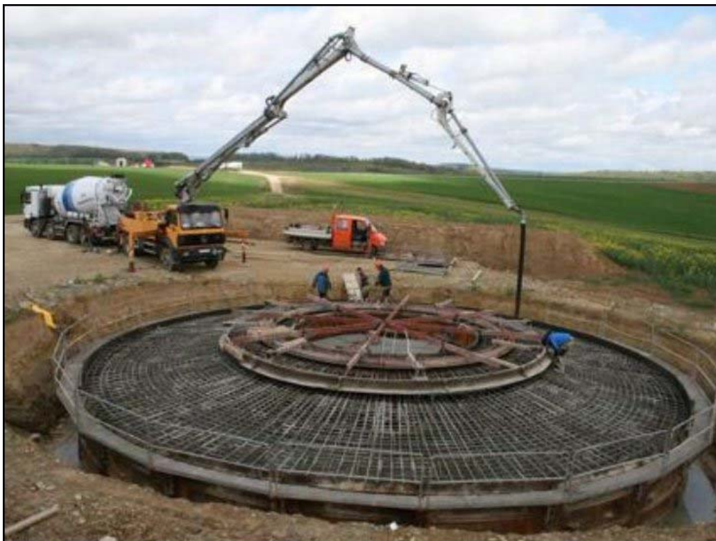
La fondation de 25 m. de diamètre et 3 m. de profondeur recevra 740 m 3 de béton soit 1700 tonnes.
