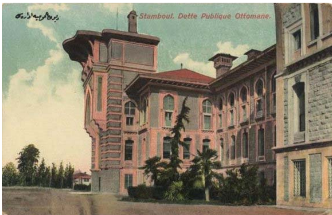
Locaux de l'Administration de la Dette Publique Ottomane, Constantinople
