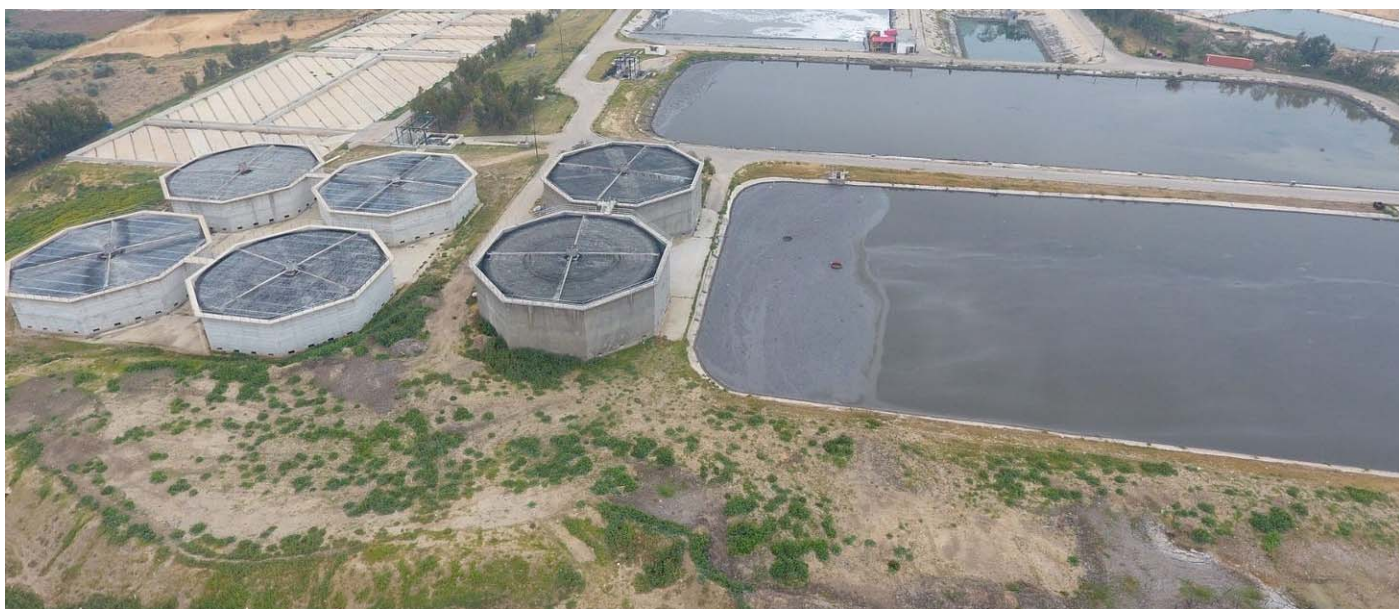
Station d'épuration de Sheikh Ajlin. Photo: Contrat de MACC.
