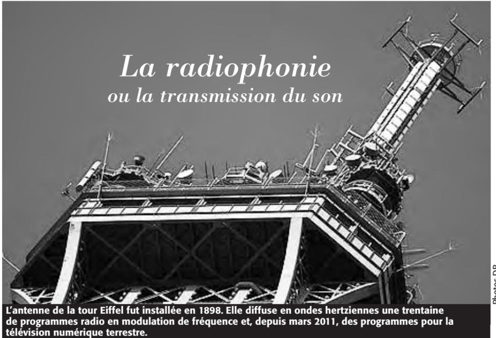
L'antenne de la tour Eiffel fut installée en 1898. Elle diffuse en ondes hertziennes une trentaine de programmes radio en modulation de fréquence et, depuis mars 2011, des programmes pour la télévision numérique terrestre.
